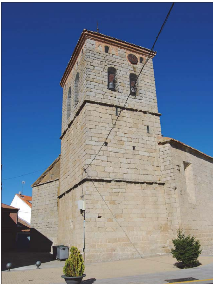
La torre vista desde su ángulo suroeste.
