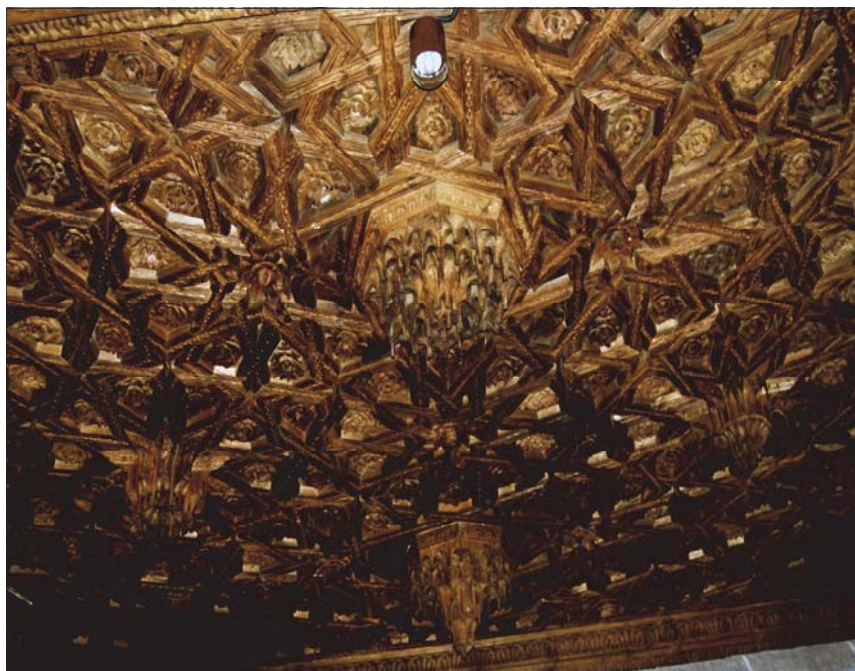
Detalle del bajo coro en la nave central.
